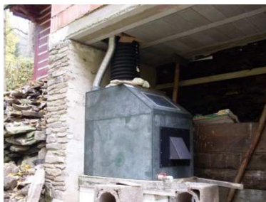
Obr. 4 zabudování šachtového kontejneru
