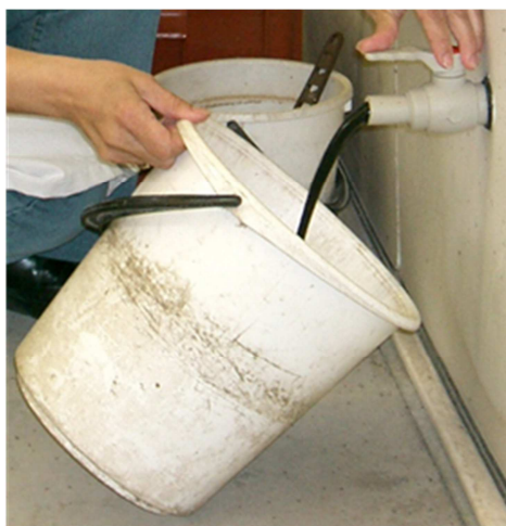
Obr. 1 Odtah přebytečného kalu z domovní ČOV
