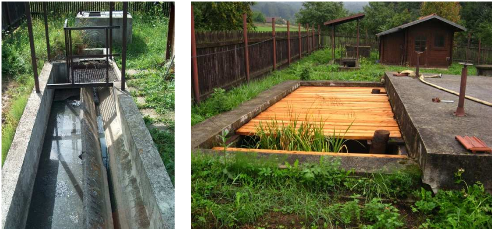
Obr. 4 Štěrbínový lapák písku (vlevo) a pohled na usazovací nádrž s boční vyhnívací komorou (vpravo)
