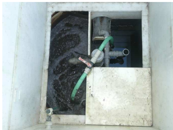
Obr. 2 Pohled do balené aktivační ČOV pro 4 EO
