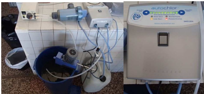
Obr. 9 Zapojení zařízení s elektrolytickou celou Autochlor
