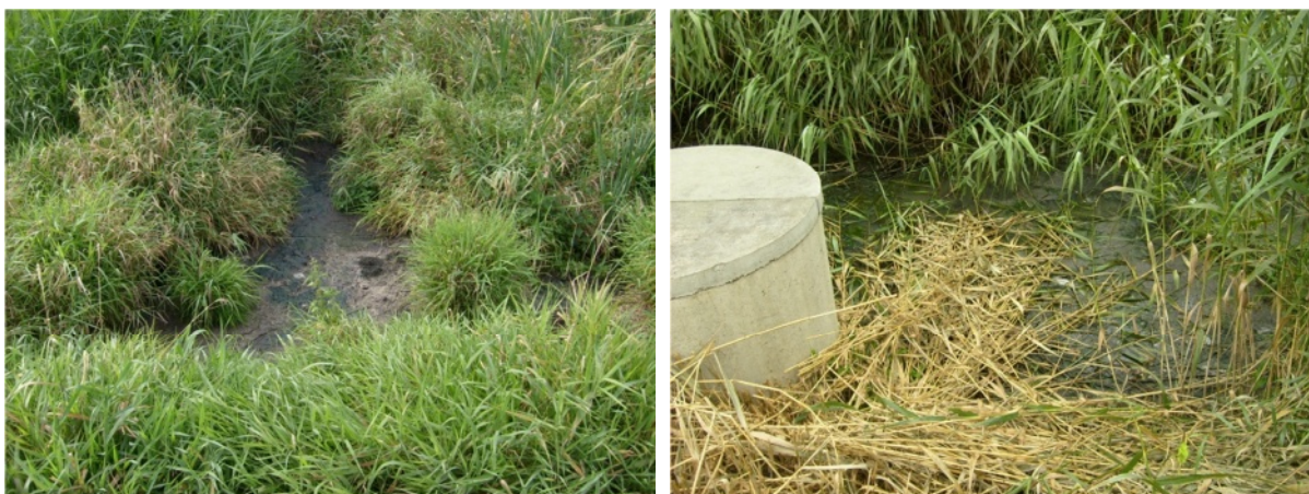
Obr. 3 Ukázky vzestupu hladiny vody v kolmatované přítokové zóně (foto archiv VÚV)
