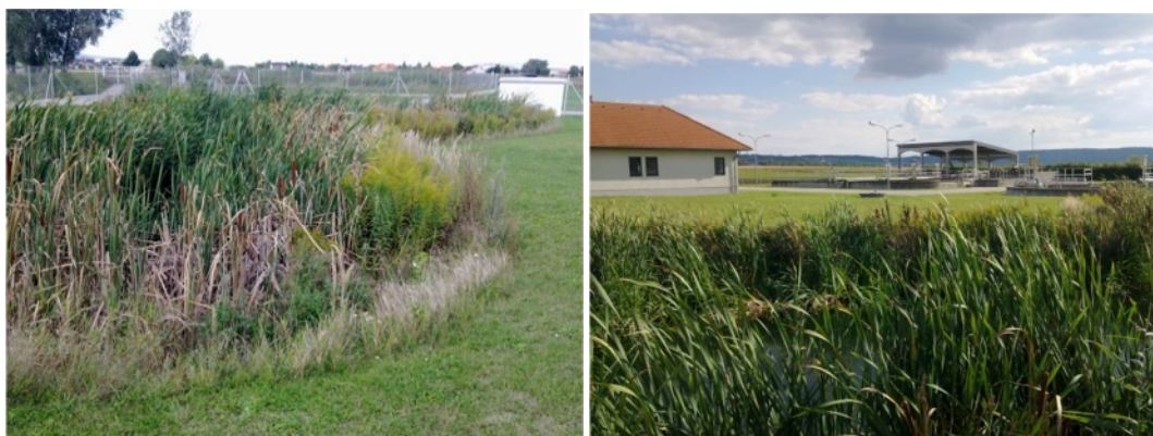
Obr. 1 Pohled na litorální zónu biologické nádrže (v pozadí kořenové filtry) a na prostor čistírny Harmannsdorf (vpravo)
