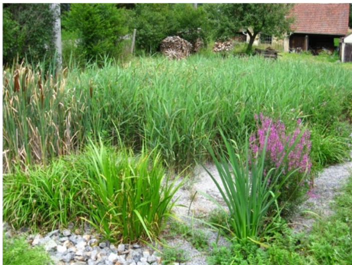
Obr. 2 Umělý mokřad – horizontální kořenový filtr čistírny kategorie 10 – 50 EO
