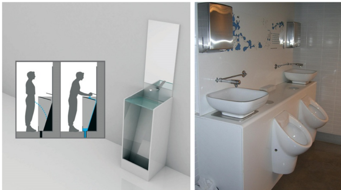
Obr. 4: Zapojení umyvadel na splachování pisoárů
